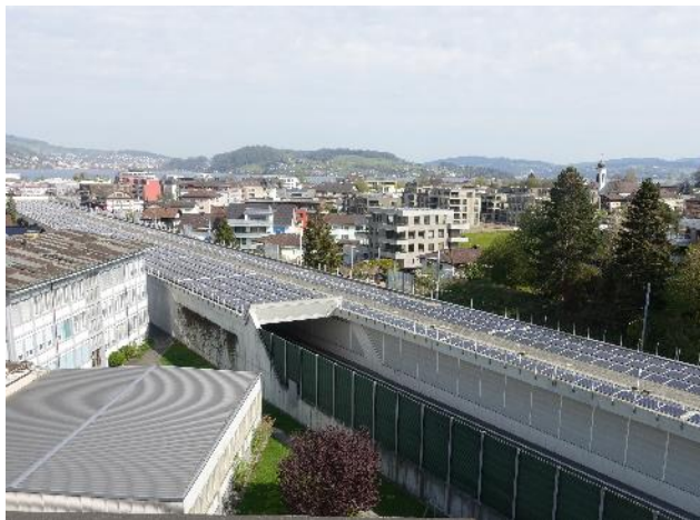
Autobahnüberdachung Stansstad (Bild: Walter Odermatt)
