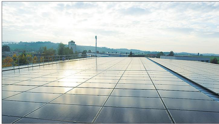
Die PV-Anlage auf dem Dach der Dreifach-Sporthalle liefert in Zukunft Strom für umgerechnet 45 Haushaltungen (entspricht 220000 Kilowatt-Stunden).
