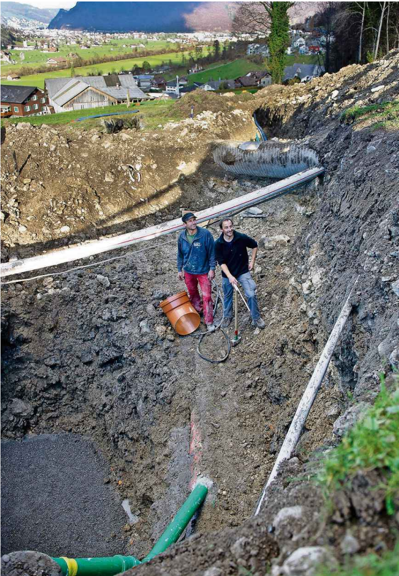
Heinz Barmettler (rechts) und Robi Kaufmann auf der Baustelle für ihr Wasserkraftwerk. Bild Corinne Glanzmann
