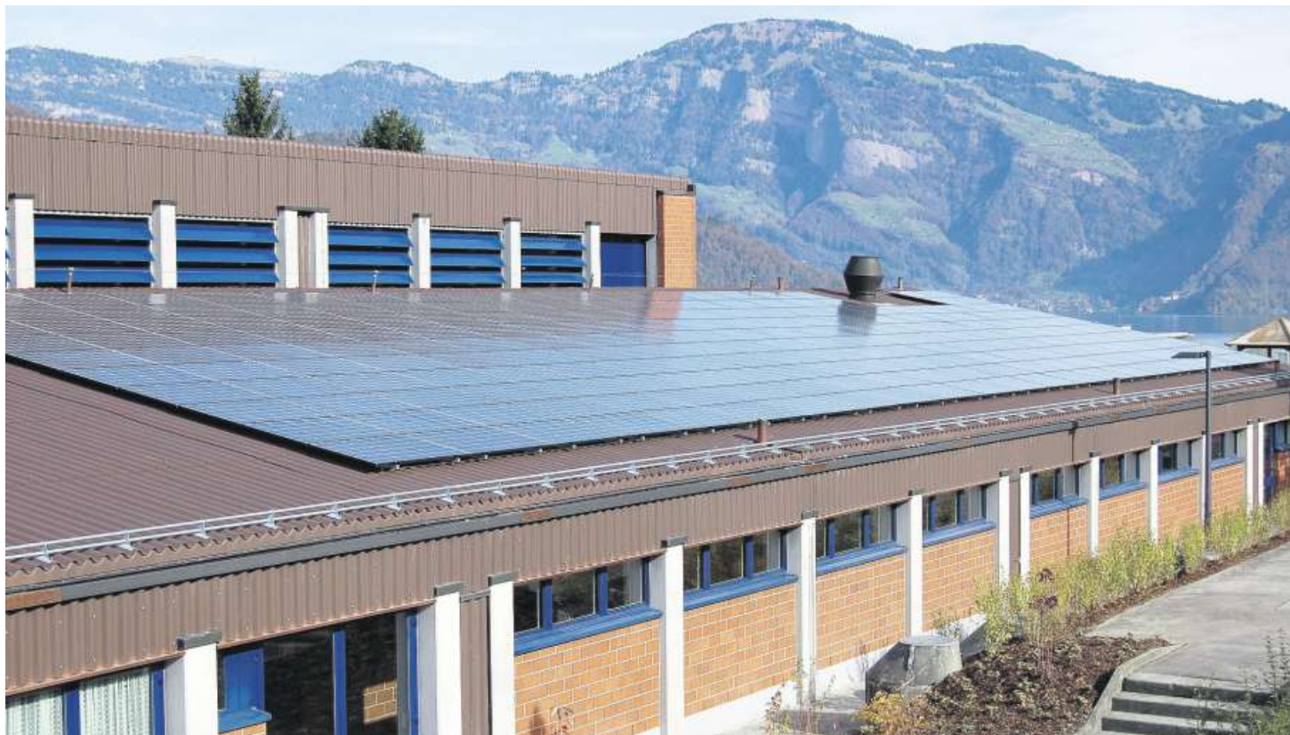
Seit Herbst 2013 in Betrieb: die Solaranlage auf dem Dach der Turnhalle in Buochs.
