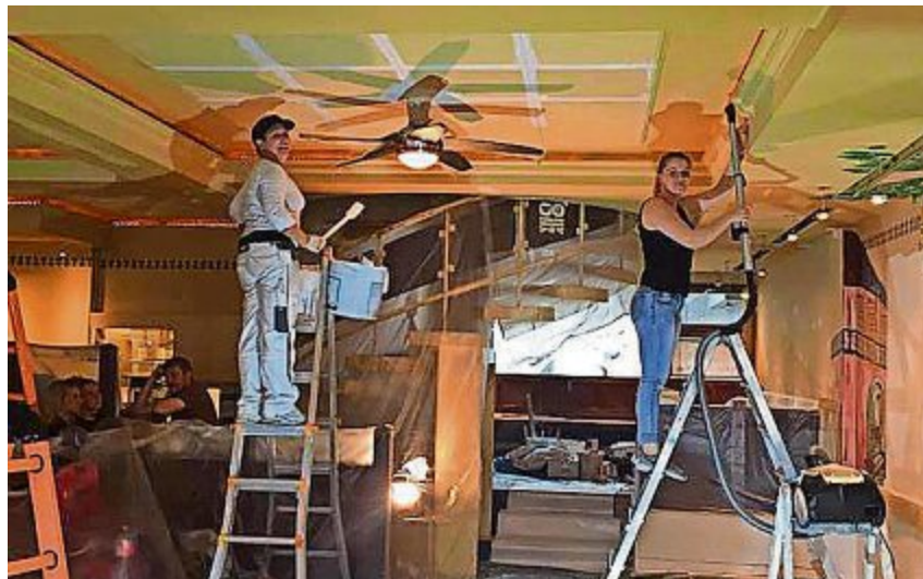
Die Umbauarbeiten im Restaurant El Divino sind abgeschlossen.
