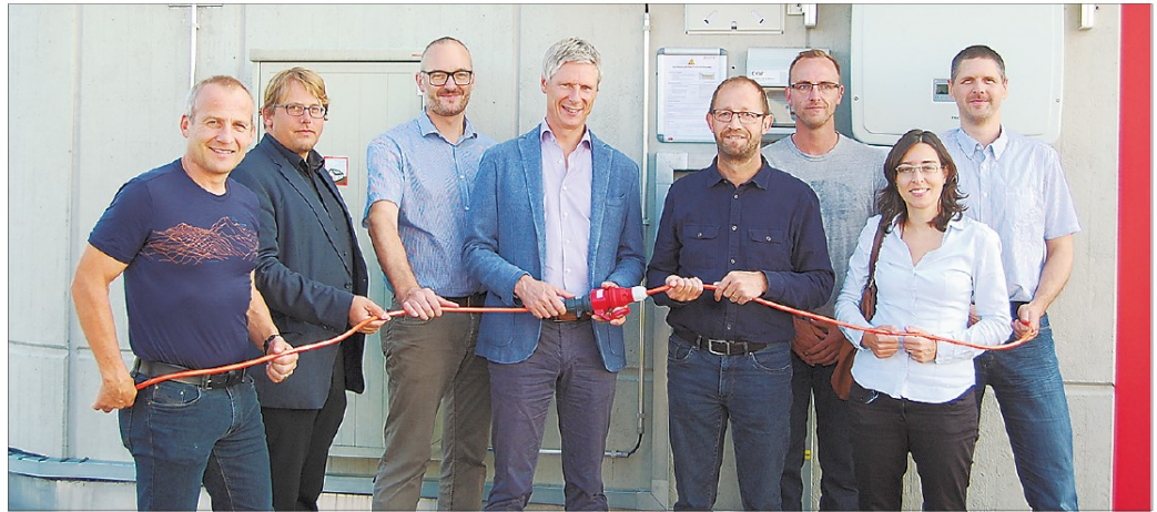
Der Vorstand der Energiegenossenschaft Buttisholz mit einer Vertretung des Gemeinderats und der Realisierungsfirmen stellten bei der offiziellen Einweihung der Photovoltaik-Anlage die Verbindung zwischen Wechselrichter und Hauptverteilung her. Foto zVg
